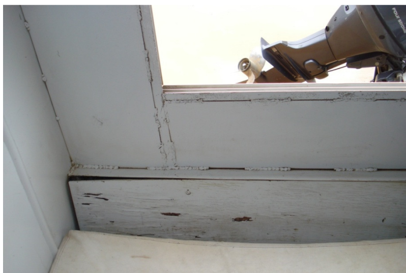
Imagem 3 (substituição do revestimento de madeira das laterais por chapa de alumínio 2 mm)
